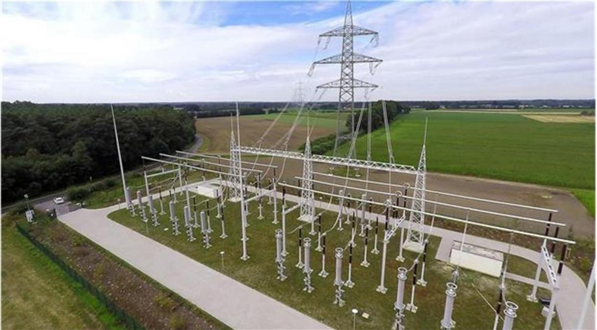
**Abbildung 6: Höhenunterschiede zwischen einem 380-kV-Mast und einer Kabelübergabestation (KÜS) bei Raesfeld im Münsterland (Amprion GmbH 2019).**
